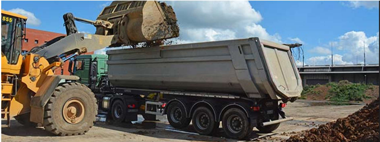
Verladung von Klärschlamm per Radlader
